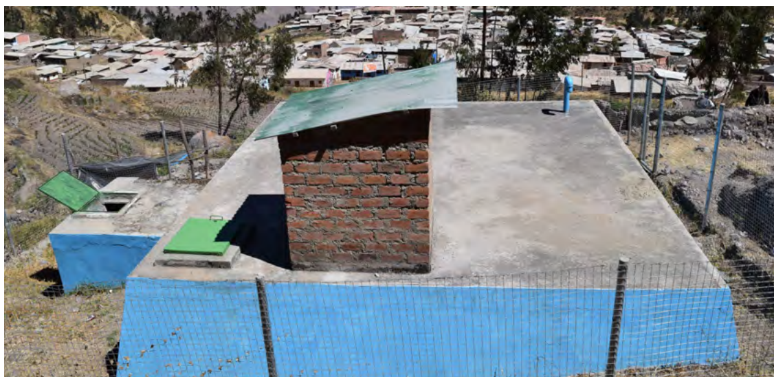
» Figura 4.4: Tanque de almacenamiento de agua de Tupicocha con una caseta para la dosificación de cloro en la parte superior. Imagen: M. Krauss.
