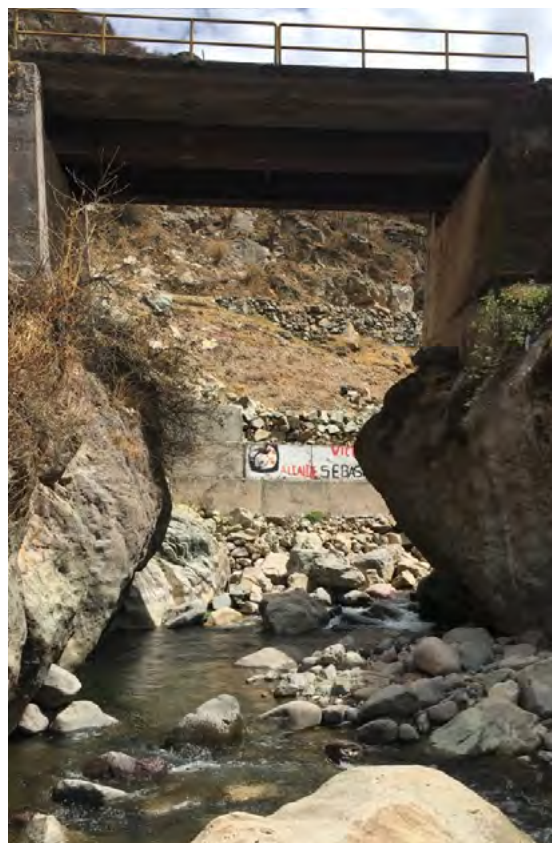
» Figura 2.4 : Estación hidrométrica en Santa Rosa de Quilquichaca (3 000 msnm): Vista de la instalación en la orilla derecha del río desde el puente de arriba (el río fluye hacia la izquierda); el rectángulo destaca el tubo de la instalación, que tiene una longitud de unos 10 m (izquierda). Sección transversal y parte del lecho del río bajo el puente, mirando hacia arriba (derecha). Imágenes: S. Schroers.
