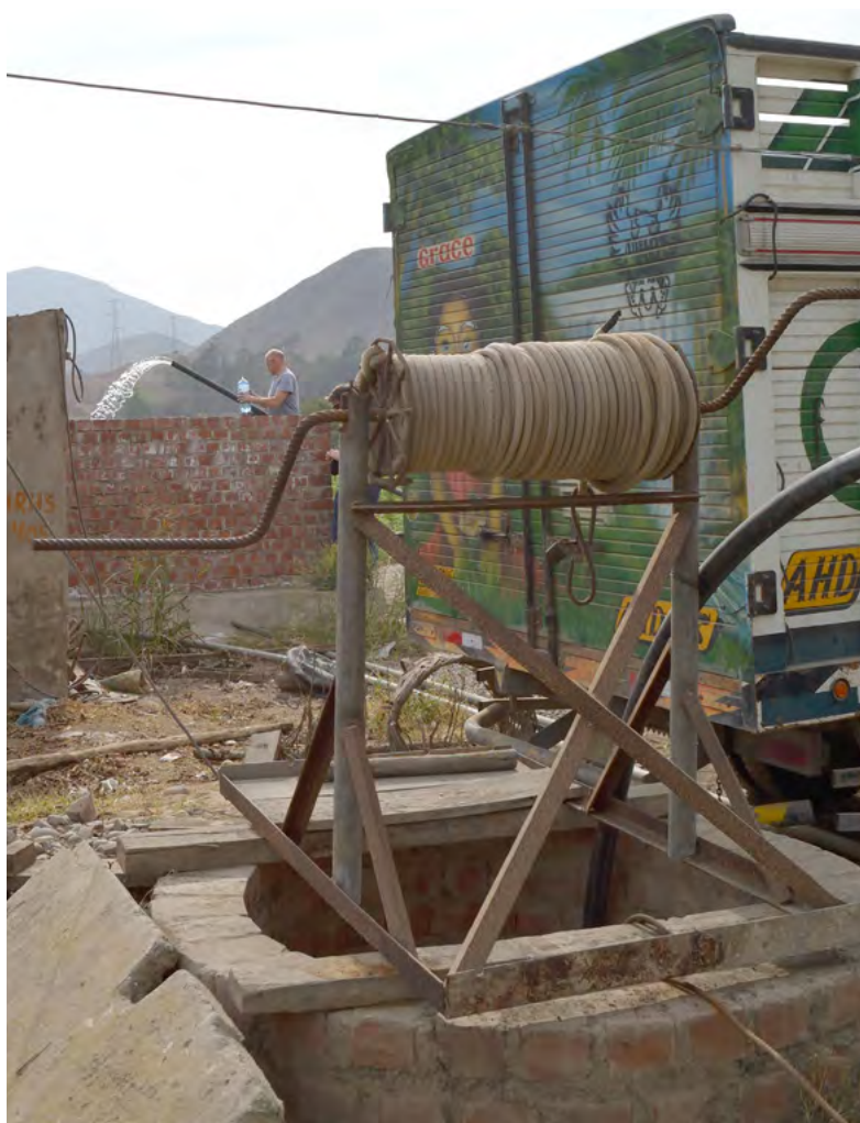
» Figura 5.3: Pozo artesanal a tajo abierto en la cuenca baja del río Lurín (Manchay). Imagen: M. Krauss.
